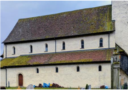
teilweise gereinigtes Dach
