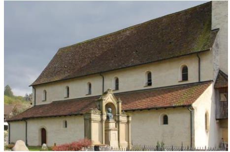
gereinigtes und ausgebessertes Dach
